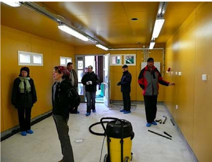
Rakenteilla olevat jatkojalostustilat. Kuva Sampo Keskinen
